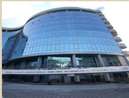
Фото 21. Завершується будівництво бібліотечного корпусу Університету
