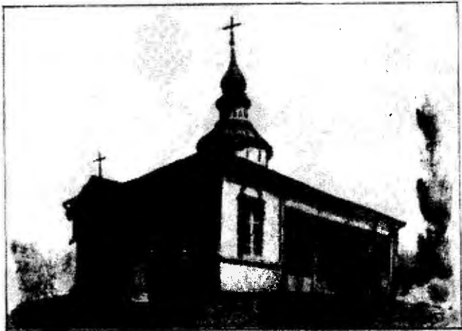
Церква, перебудована з будинку П. Полуботка
